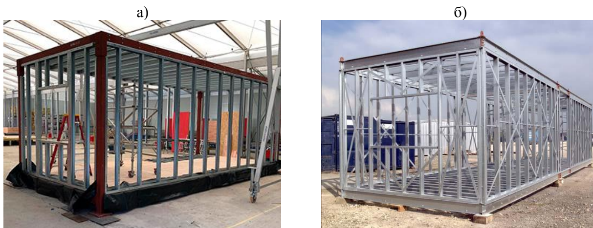
Рисунок 2. Каркасные системы модулей: а) с опорными угловыми стойками ( https://www.stentprojects.co.uk/modular/#about-modular ); б) с несущими стенами [18]
