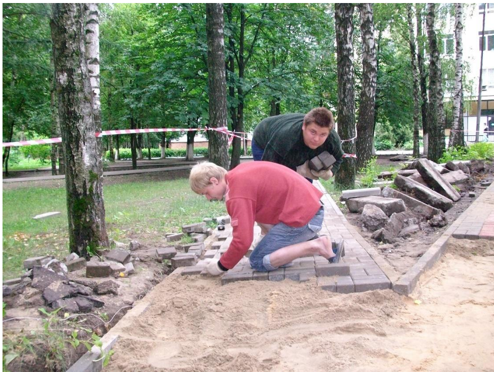
Рисунок 4. Замена студентами БГИТУ асфальтобетонного покрытия дорожек на плиточное покрытие в сквере возле корпуса БГИТУ (выполнен авторами)
