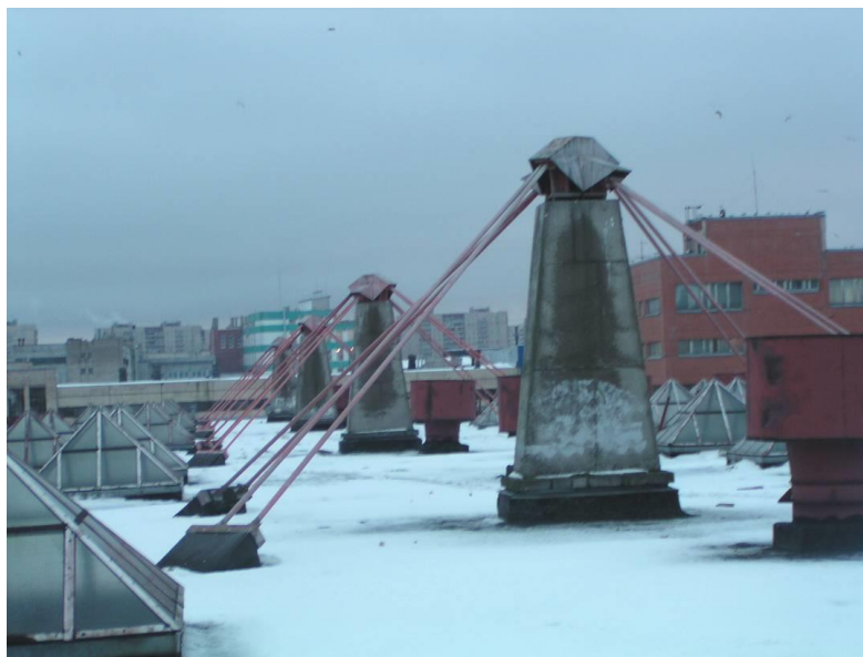
Рисунок 18. Общий вид вантовой конструкции перекрытия
