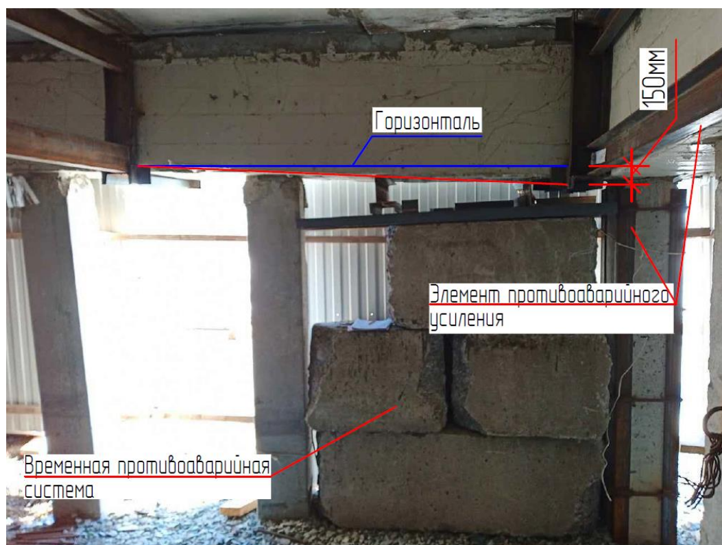
Рисунок 1. Изменение горизонтального положения ростверка в следствии неравномерной провальной осадки фундаментов (составлено авторами)
