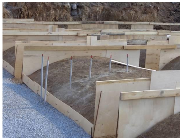
б) Опалубочные работы
