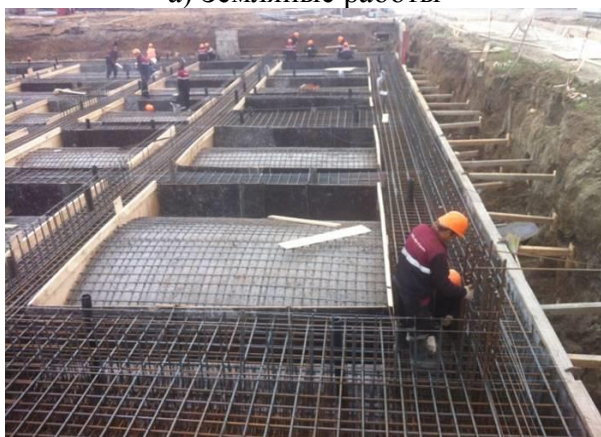
в) Арматурные работы
