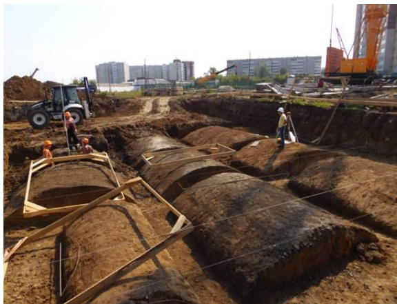
а) Земляные работы
