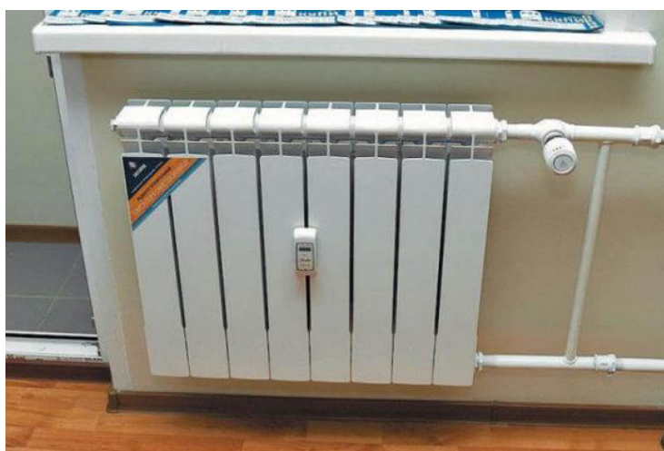
Рисунок 1. Радиаторный распределитель, установленный на отопительном приборе в здании с вертикальной системой отопления (составлено авторами)
