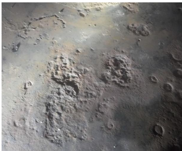
Рисунок 4. (а) коррозия днища резервуара; (б) коррозия днища резервуара; (в) коррозия днища резервуара (составлено авторами)
