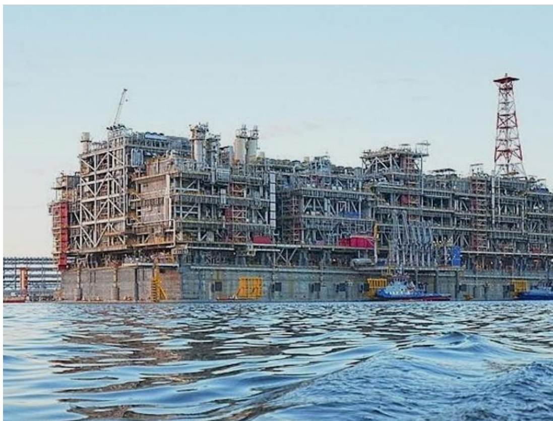
Рисунок 8. Монтаж бетонного основания гравитационного типа (ОГТ) 6
