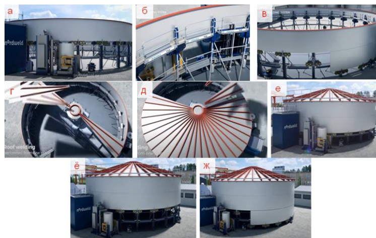
Рисунок 7. Основные технологические процессы (монтаж второго пояса — монтаж элементов крыши — монтаж последнего (нижнего) пояса) сборки вертикальных стен из рулонной стали высотой на один пояс с применением подъемной системы Lift Jack: а — подъем верхнего (первого) пояса; б, в — пережатка завальцованной рулонной стали последующего (второго сверху) пояса по периметру РВС; г, д — сборка конструкций крыши РВС; е, ё — подъем собранных двух поясов и крыши; ж — завершение подрачивания последнего пояса РВС ( https://www.youtube.com/watch?v=Mp4AeMoFviA )
