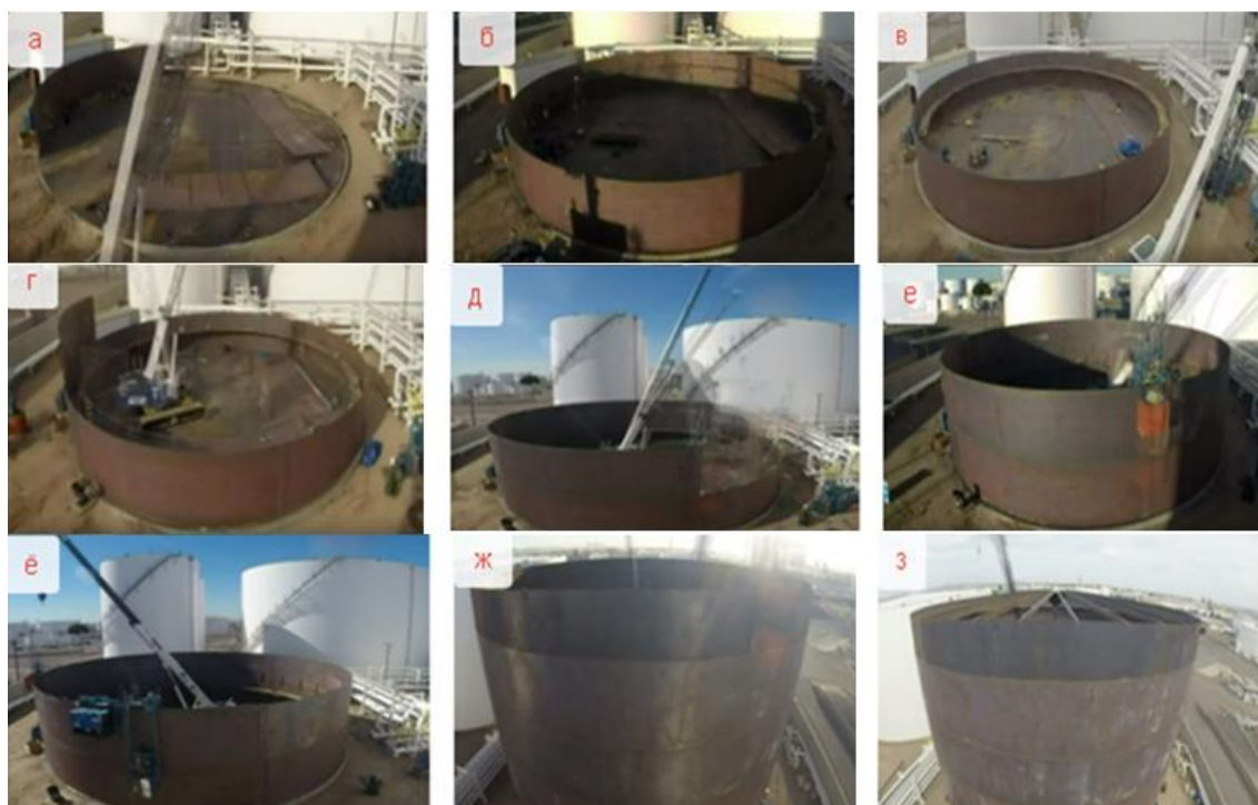
Рисунок 10. Основные технологические процессы полистовой сборки вертикальных стен PVC способом наращивания: а — начало наращивания первого снизу пояса; б — полностью собранный первый пояс; в — установка подмостей внутри резервуара для безопасного обеспечения рабочего места; г, д — процессы сборки второго пояса с помощью крана, находящегося внутри резервуара; е, ё — процессы очистки и сварки стыков; ж — наращивание последнего пояса; з — установка опорного кольца и сборка конструкций крыши PVC ( https://yandex.ru/video/preview/?filmId=646472541554631616&from=tabbar&parent-reqid=1647769243472157-15662584466549460596-sas3-0749-7ac-sas-l7-balancer-8080-BAL-1850& )
