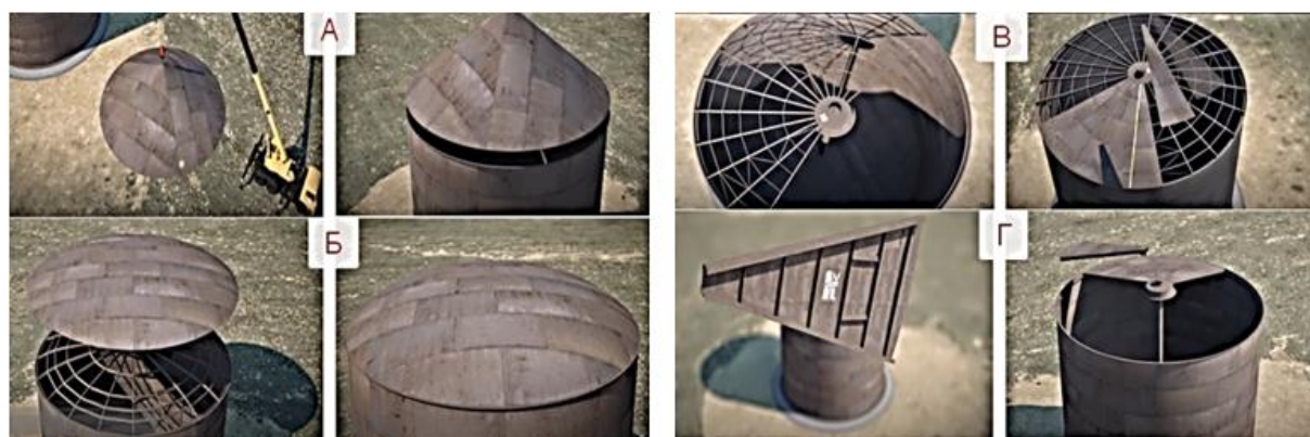
Рисунок 13. Основные виды крыши РВС: а — коническая; б — сферическая из отдельных элементов листовой стали; в — сферическая из отдельных радиальных элементов, опирающихся на решетчатые конструкции; г — сферическая из отдельных радиальных элементов, опирающихся на главную (центральную) стойку ( https://yandex.ru/video/preview/?filmId=10239757162125418555&from=tabbar&parent-reqid=1647766969131568-6746194138223389736-sas3-0749-7ac-sas-l7-balancer-8080-BAL-4229& )
