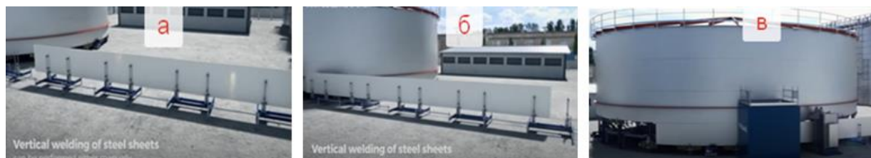
Рисунок 8. Процесс перекатки рулонной листовой стали (на пояс) для подращивания очередного пояса: а, б — процесс перекатки развернутого стального рулона высотой на один пояс с помощью столиков с колесами; в — процесс подращивания пояса ( https://www.youtube.com/watch?v=Mp4AeMoFviA )
