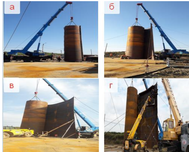
Рисунок 11. Основные технологические процессы сооружения РВС способом рулонирования: а — установка рулона корпуса (вертикальной части) на готовое днище с помощью гусеничного крана; б, в, г — процесс развертывания рулона ( http://www.мск-юг.рф/portfolio/montazh-rvs-10000m3.html )
