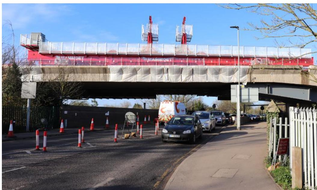
**Рисунок 2.** Демонтаж балок пролетного строения [8]
