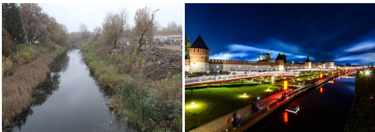
Рисунок 3. Казанская набережная г. Тулы: до и после ревитализации ( https://archi.ru/projects/russia/11869/rekonstrukciya-naberezhnoi-reki-upy-tula )
