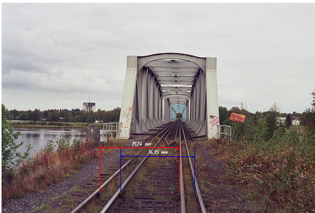
Рисунок 3. Разница между колеями Финляндии и Швеции 2
