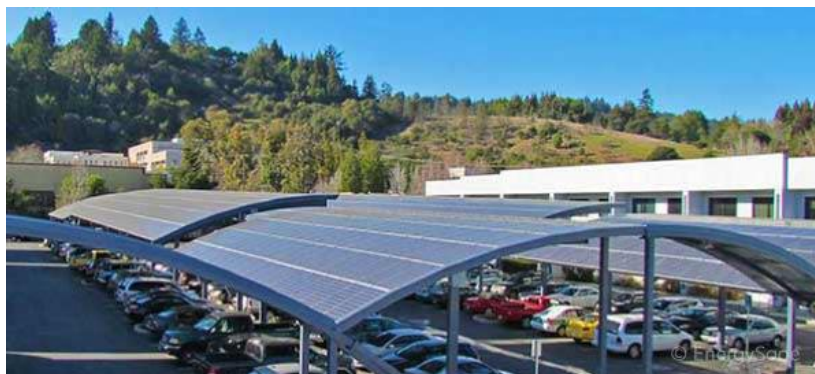
Рисунок 9. Автостоянка с солнечными навесами
