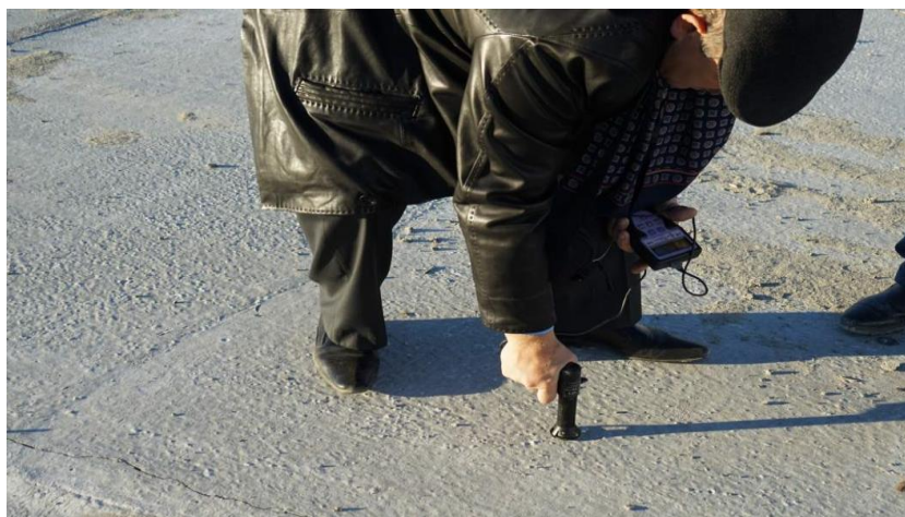
Рисунок 2. Проверка прочности бетона измерителем прочности бетона ИПС-МГ4.03 (выполнено авторами)
