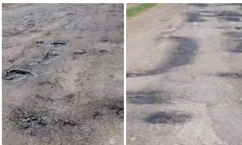
Рисунок 4. Эксплуатация дорожного покрытия после ремонта (сохранение структуры с асфальтовым гранулятом) (фото выполнено авторами)
