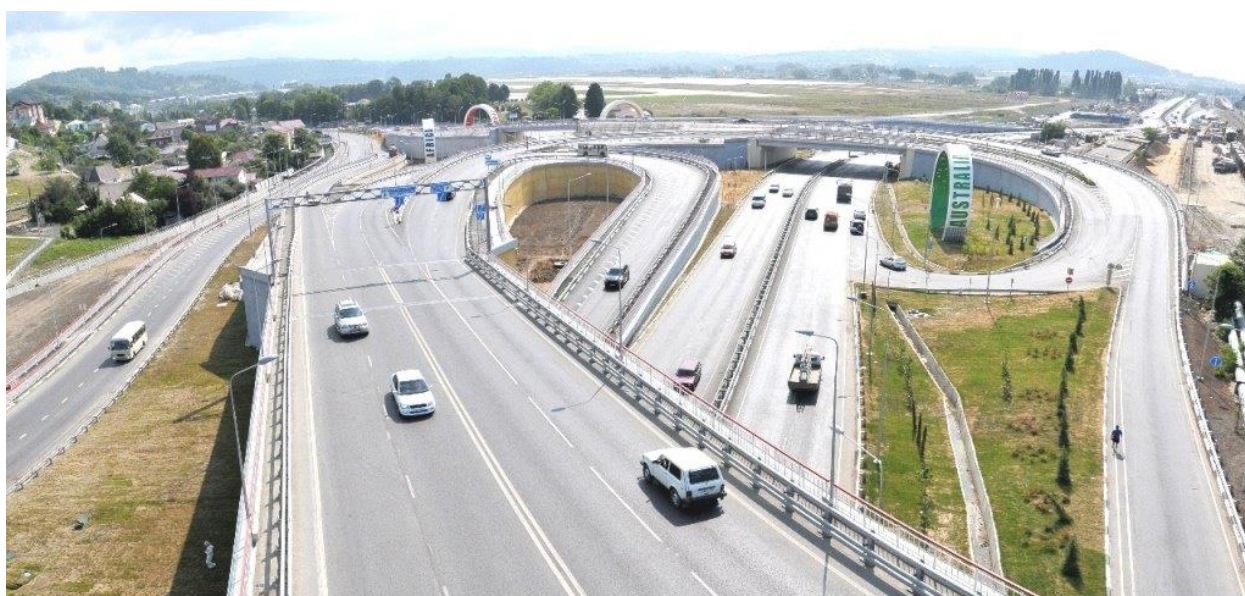
Рисунок 5. Транспортная развязка автодороги Джубга — Сочи: Адлерское кольцо 3
