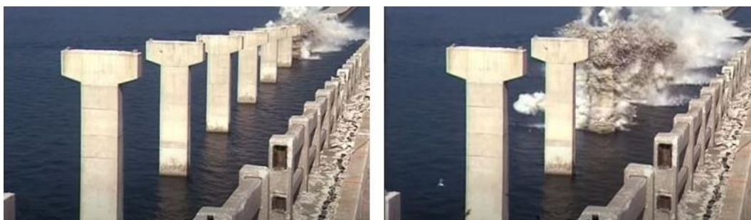
Рисунок 3. Процесс подрыва железобетонных опор моста Саншайн-Скайуэй имени Боба Грэма (источник электронный ресурс URL: https://www.youtube.com/watch?v=zYVJaE2wUvQ , дата обращения 22.05.2021)
