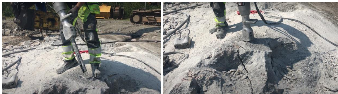
Рисунок 1. Гидравлический клин С9 компании DARDA в работе (фото авторов)
