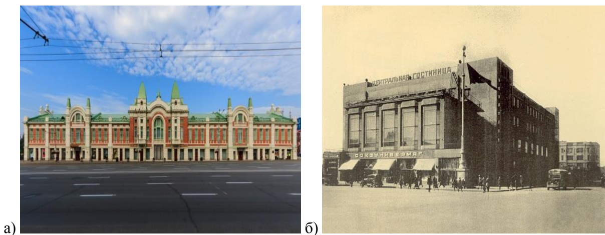
Рисунок 2. а) План и фасад Торгового корпуса (источник: https://ru.wikipedia.org/wiki/Городской_торговый_корпус ); б) Доходный дом (источник: http://nsk.novosibdom.ru/node/344 )
