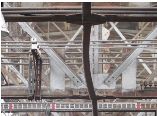
Рисунок 14. Выгибы из проектной плоскости связей по колоннам, верхним и нижним поясам ферм (фото составлено Таранухина В.О., Мегедь Т.К., Ильенко М.Ш., Соловьева Е.В.)
