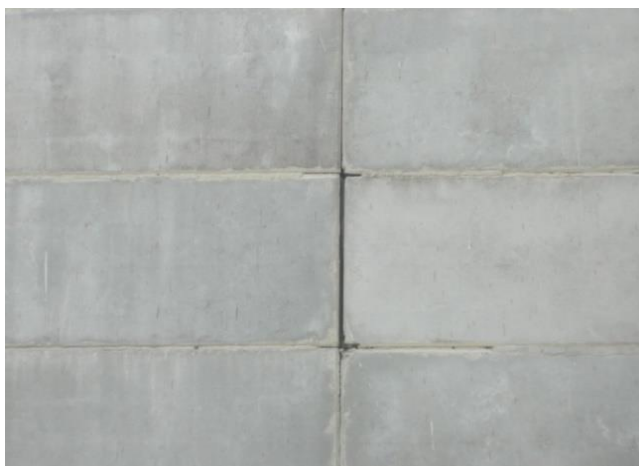
Рисунок 8. Разрушение герметизации швов стеновых панелей (фото составлено Таранухина В.О., Мегедь Т.К., Ильенко М.Ш., Соловьева Е.В.)
