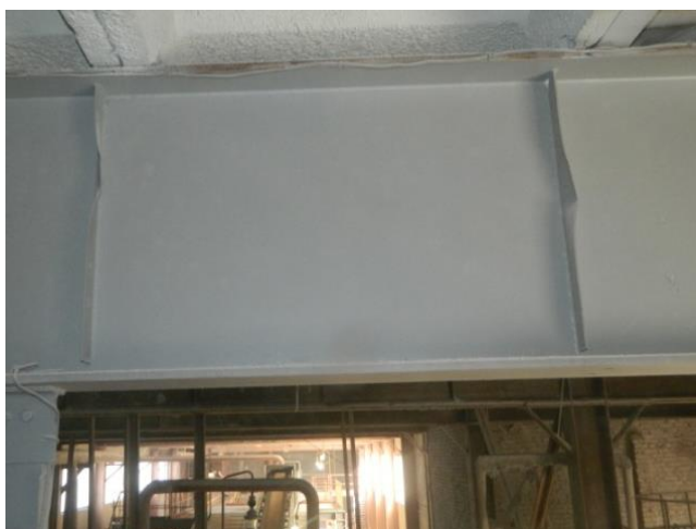
Рисунок 17. Выгибы полок и ребер жесткости в балках перекрытия и покрытия (фото составлено Таранухина В.О., Мегедь Т.К., Ильенко М.Ш., Соловьева Е.В.)
