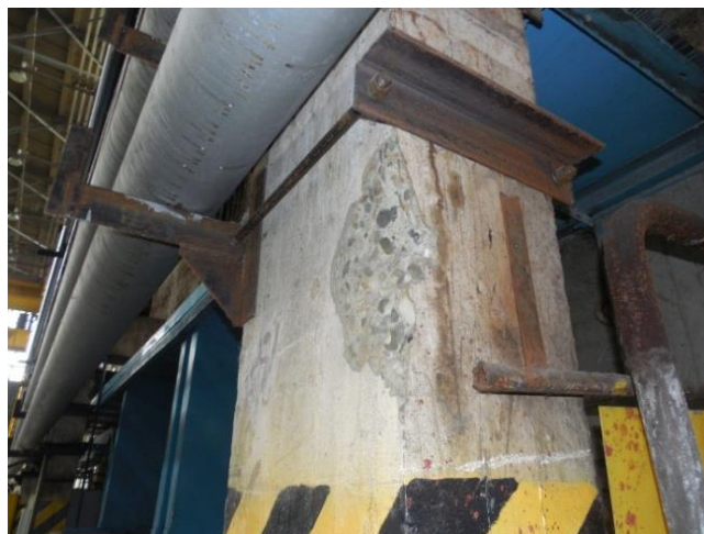
Рисунок 19. Скол бетона в колоннах каркаса здания (фото составлено Таранухина В.О., Мегедь Т.К., Ильенко М.Ш., Соловьева Е.В.)
