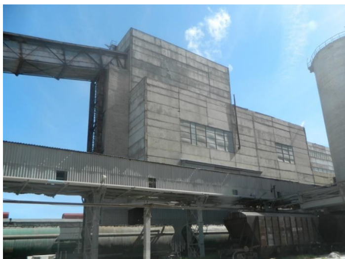
Рисунок 1. Здание фасовки и погрузки НПК ОАО «Дорогобуж» (фото составлено Таранухина В.О., Мегедь Т.К., Ильенко М.Ш., Соловьева Е.В.)
