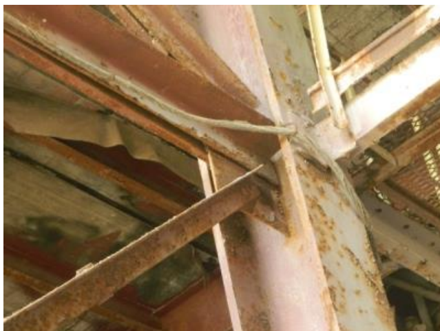
Рисунок 16. Разрушение сварного шва узла крепления связей к колоннам и фермам (фото составлено Таранухина В.О., Мегедь Т.К., Ильенко М.Ш., Соловьева Е.В.)
