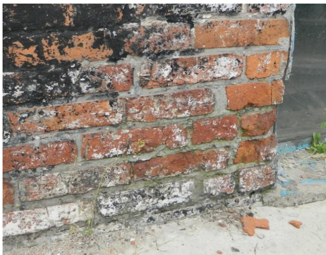
Рисунок 13. Разрушения кирпича лещадками (фото составлено Таранухина В.О., Мегедь Т.К., Ильенко М.Ш., Соловьева Е.В.)
