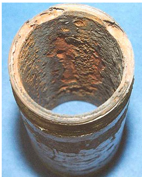
Рисунок 2. Отрезок НКТ с примерами общей и питтинговой коррозии 5
