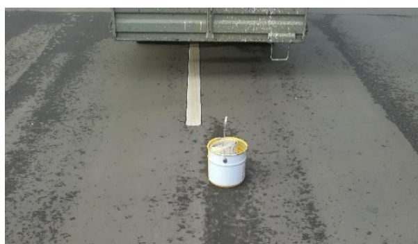
Рисунок 7. Нанесение автором термопластика производства ООО ПХ «Технопласт» (фото автора)
