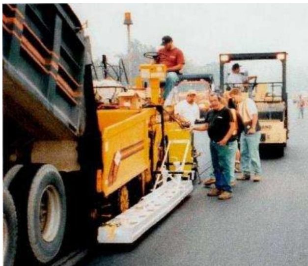
Рисунок 1. Разогрев продольных швов при помощи инфракрасного разогревателя, размещённого на асфальтоукладчике (взято из источника [1])
