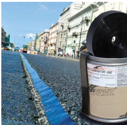
Рисунок 3. Укладка битумно-полимерной стыковочной ленты (взято из источника 2 )
