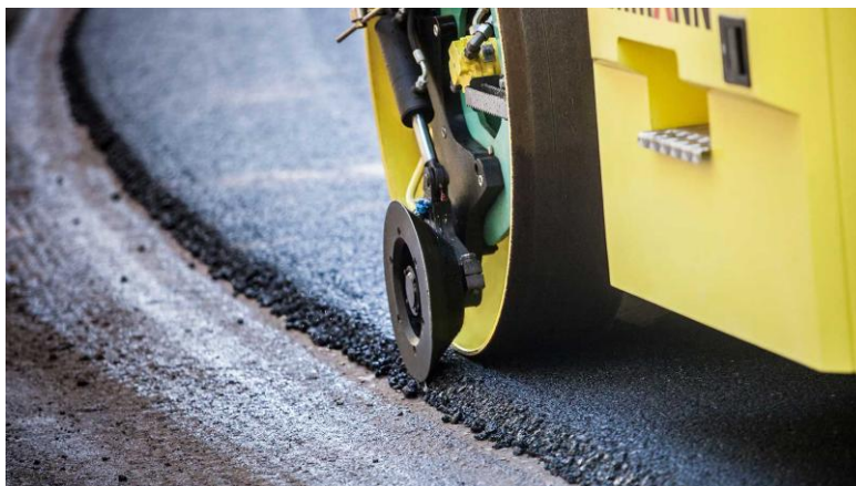
Рисунок 5. Формирование кромки покрытия при помощи краевого уплотнителя (взято из источника 8 )
