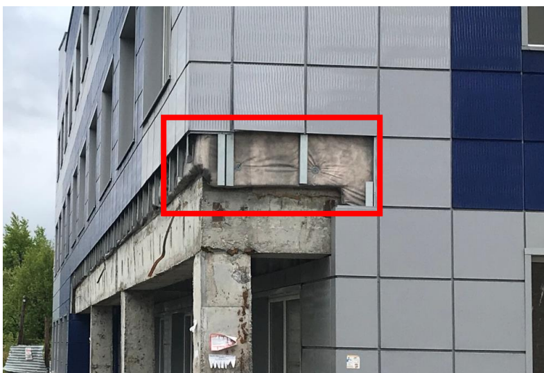
Рисунок 3. Загрязнение влаго-ветрозащитной мембраны в процессе эксплуатации (разработано авторами)
