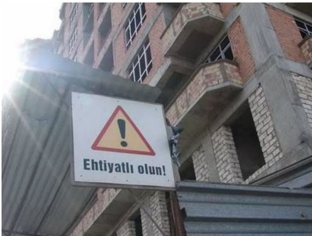
Рисунок 1. Здание «пилотного проекта» реновации в первом микрорайоне г. Баку, 2019 г. ( https://media.az/read/1067704908 Дата обращения 8.8.2019)
