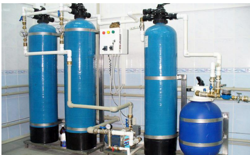
Рисунок 2. Установка ионообменной фильтрации (составлено авторами)
