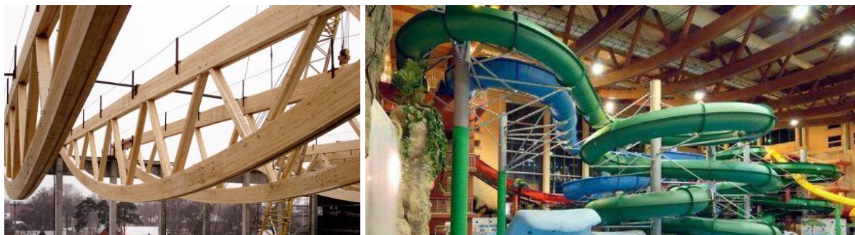
Рисунок 10. Аквапарк в г. Москва. Ферма пролетом 44 м. Фермы покрытия в аквапарке г. Санкт-Петербурга (разработано y-dom.com.ua/i9910.html )
