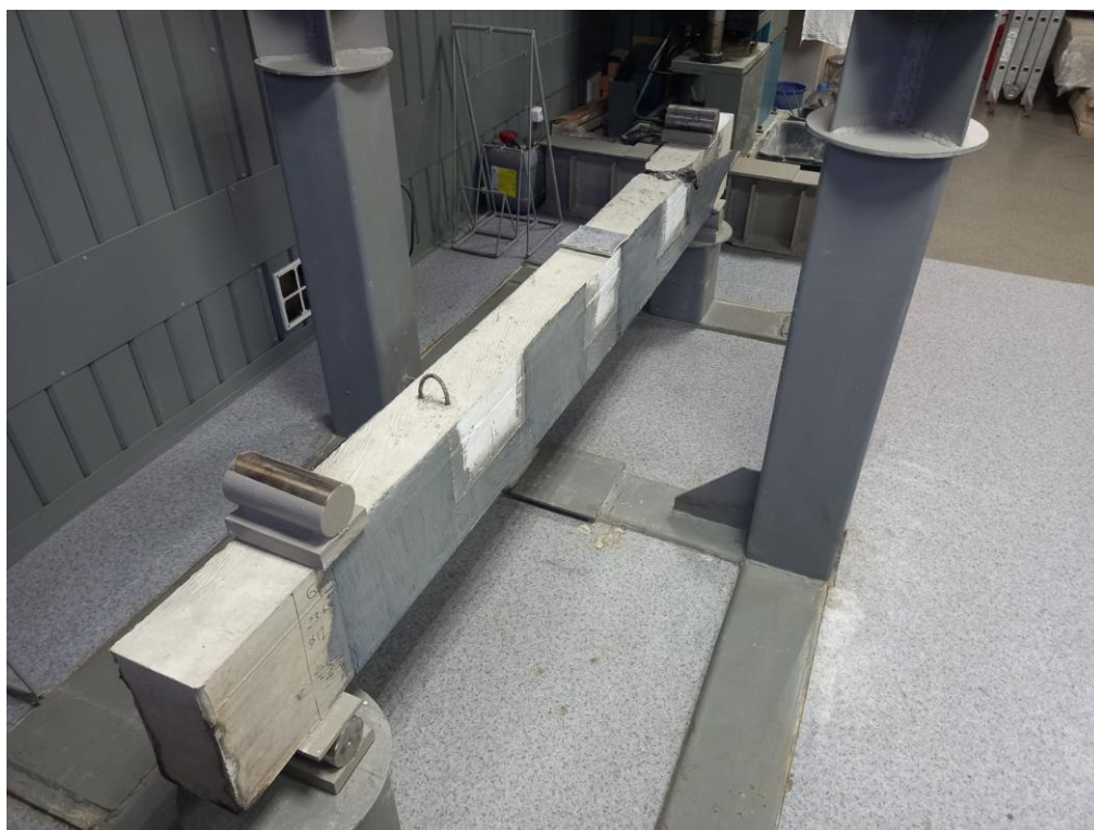
Рисунок 6. Общий вид балки, усиленной углехолстом (фото авторов)
