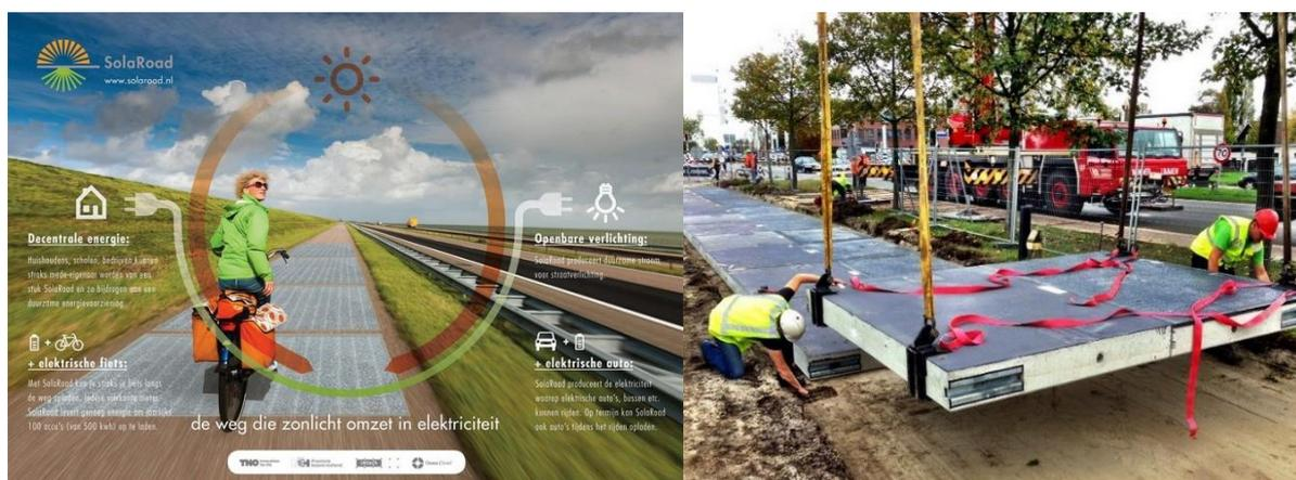
*Рисунок 3. Устройство велосипедной дорожки, состоящей из солнечных панелей<sup>3</sup>*
