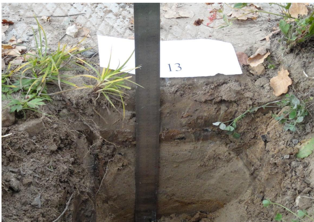
Рисунок 6. Измерение толщины сборной железобетонной плиты, слоя из пескоцемента и слоя из укрепленного цементом грунта около сборной железобетонной плиты (фото выполнено авторами)
