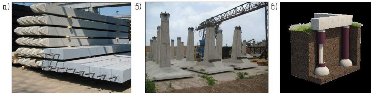
Рисунок 3. Строительно-конструктивные мероприятия: а) сваи, покрытые кремнийорганической эмалью; б) фундаменты с обратным уклоном и анкерровкой; в) анкерные сваи по технологии индивидуального строительства и экологии (ТИСЭ) (составлено авторами)
