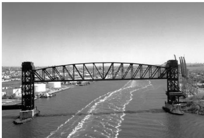
Рисунок 4. Вертикально-подъемный мост Артура Килла, США 1
