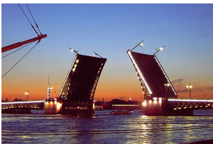
Рисунок 2. Дворцовый мост, Санкт-Петербург 1
