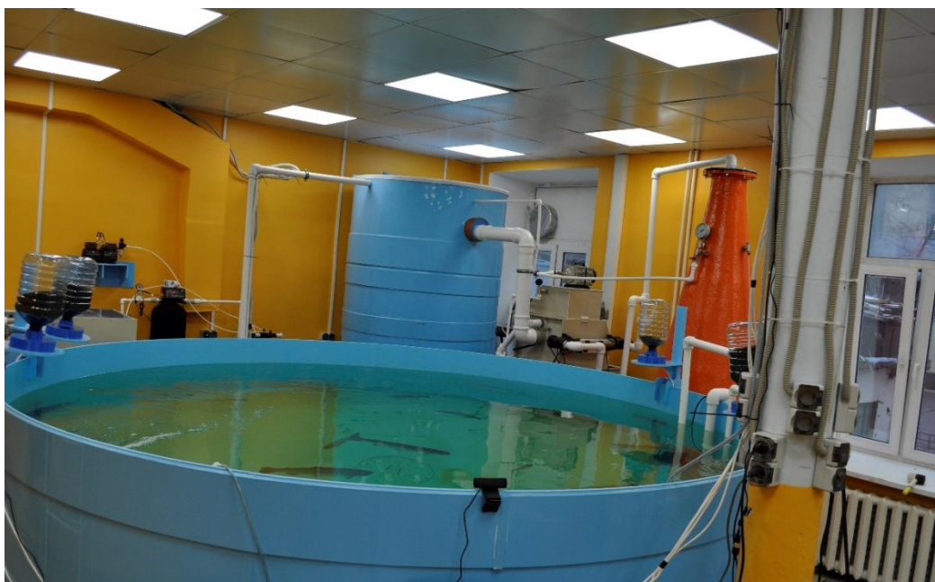
Рисунок 2. Установка замкнутого водоснабжения (в составе элементов фильтрации которой входила экспериментальная установка)
