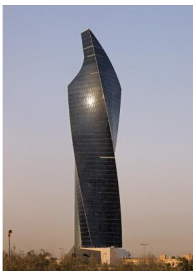
Рисунок 5. Кувейтский торговый центр – Al Tijaria Tower – (218 м) 3
